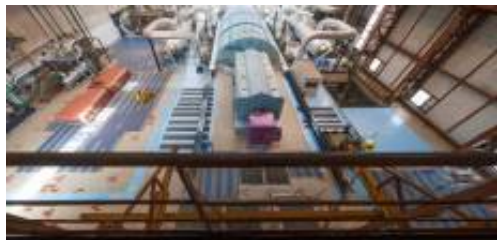
La centrale EDF de Gravelines. © EDF
