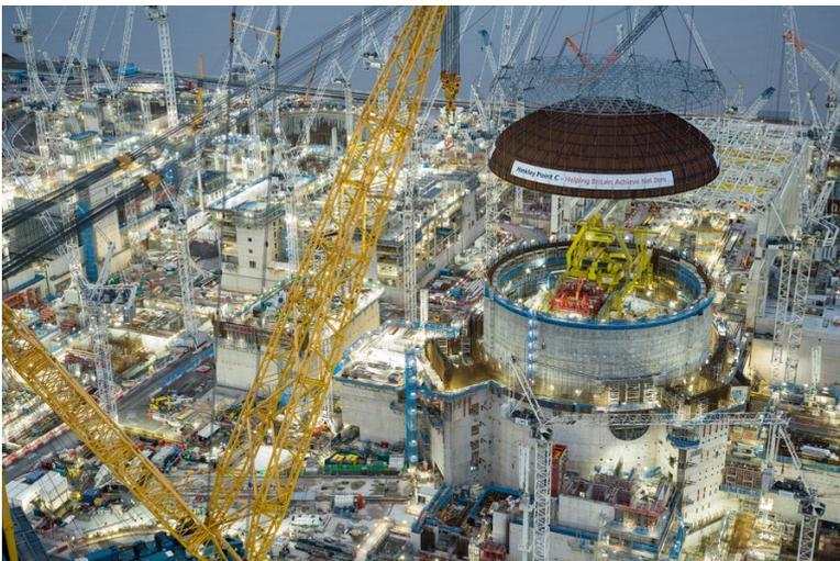
Le dôme de 47 mètres de diamètre a été construit ex situ dans un atelier temporaire afin de réaliser les 900 mètres de soudure. Les ingénieurs EDF estiment que la soudure à l'extérieur, avec une exposition au vent et la pluie, compromet le respect des normes requises du chantier. Les travaux, démarrés en mars 2017, mobilisent actuellement 10 000 personnes, constituant le plus
